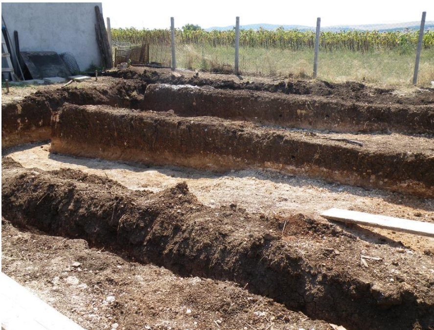
Слика 21 Правилна изведба на интегриран канал
