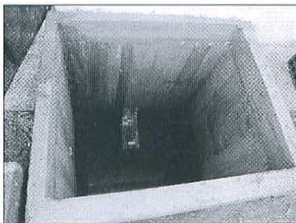
Слика 4 Бетонирана собирана јама
