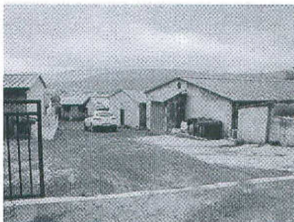
Слика 2 Производни објекти
